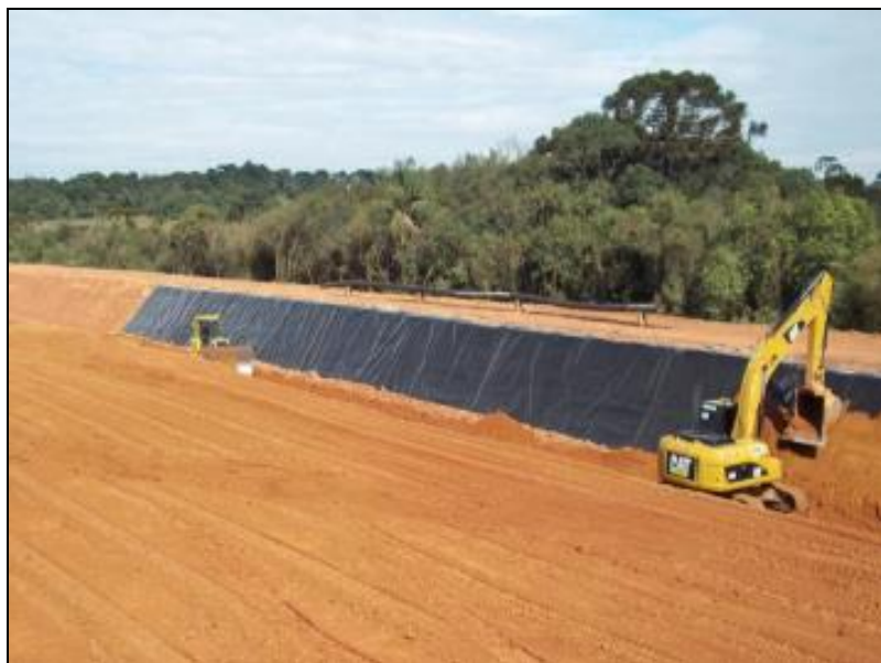
Figura 10 – Obras de Terraplanagem e Impermeabilização de base na ESTRE AMBIENTAL. Fonte: Andrade (2016).
