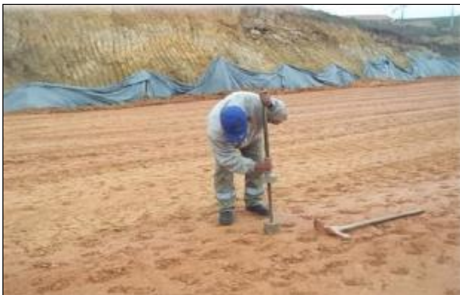
Figura 11 – Controle de Compactação no Aterro Sanitário. Fonte: Andrade (2016).
